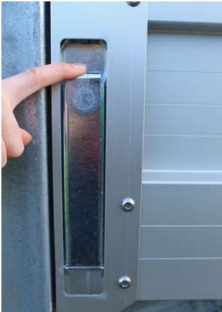
Eingelassene Langwegverschlüsse (keine herausstehenden Kanten/Hebel) bei Aluminium-Hohlkammerprofil (mit Holz in der Hohlkammer verstärkt) robust und leicht
